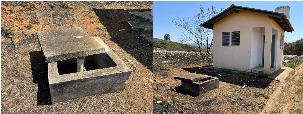
Figura 1. Fossa séptica instalada junto à guarita
