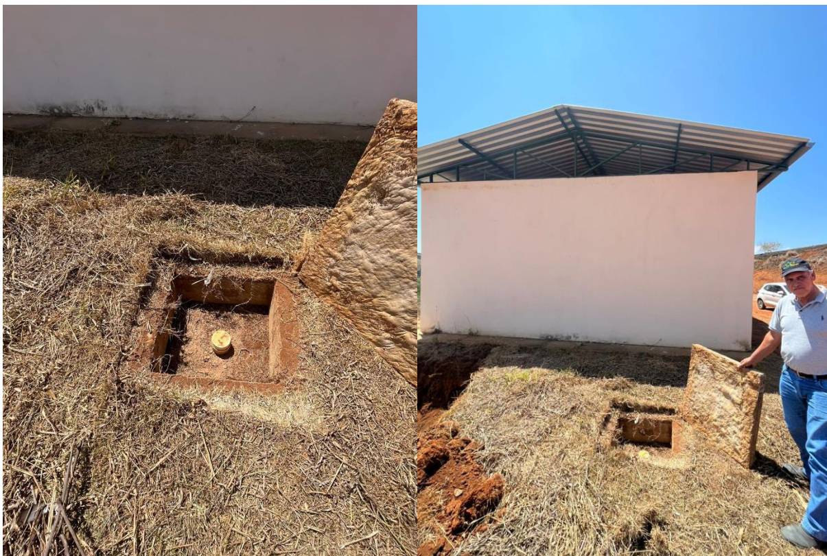
Figura 3. Fossa séptica instalada junto ao galpão de apoio
