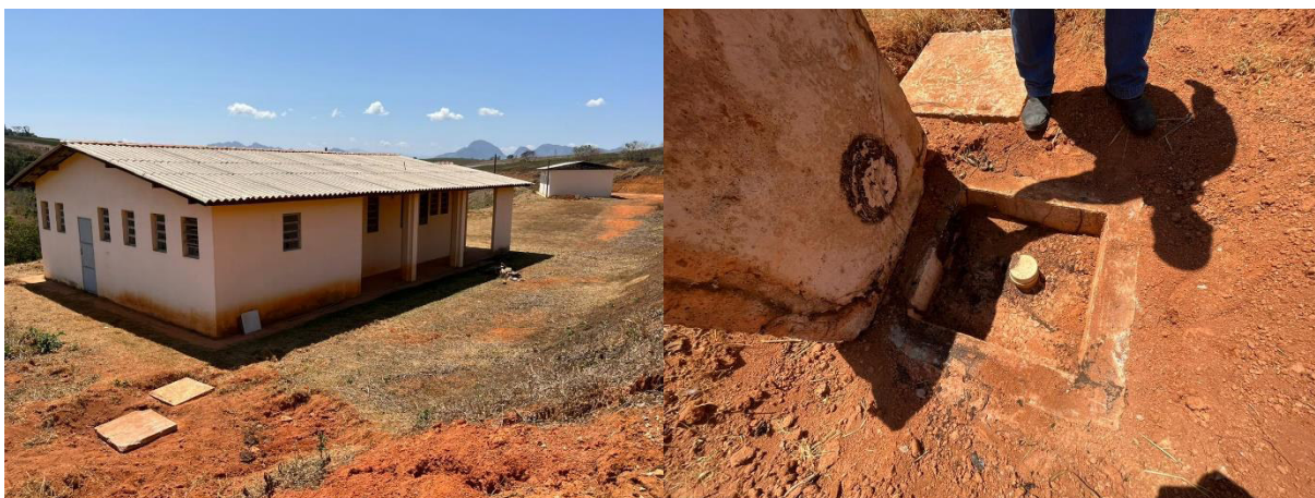
Figura 2. Fossa séptica instalada junto à sede administrativa
